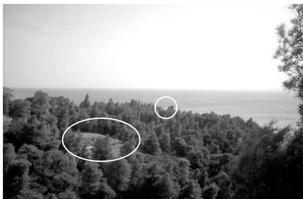
φωτογραφία 2 (βλ. παράρτημα). Διακρίνονται το εκκλησάκι του Αη Γιώργη, που ήδη υπάρχει, και οι εργασίες γι' αυτό που ετοιμάζεται.
